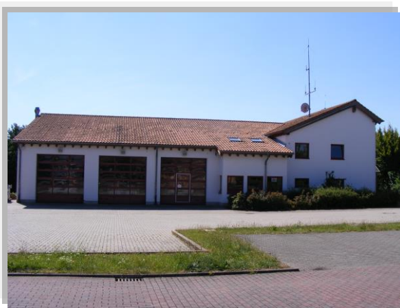
Feuerwehrgerätehaus, Am Sportfeld 2 in Rüdesheim
