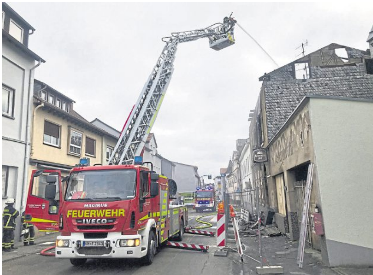
Am nächsten Morgen flammten Glutnester auf und machten weitere Löscharbeiten notwendig. Foto: Josef Nürnberg
