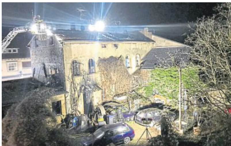
Bis tief in die Nacht waren die Feuerwehrleute im Einsatz. Die Rüdesheimer Straße blieb gesperrt. Foto: Josef Nürnberg
