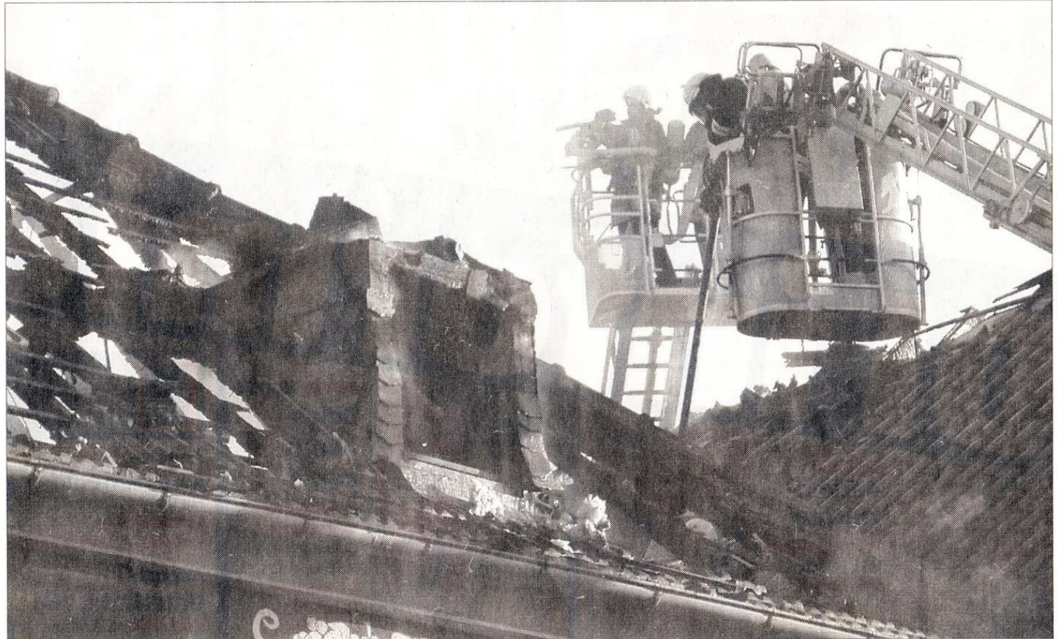
Von zwei Drehleitern aus bekämpften die Feuerwehrleute den Dachstuhlbrand dieses Hauses in der Rüdeshheimer Nahestraße.
