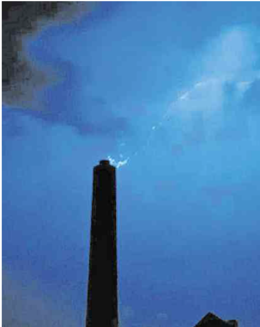
Der Schornstein der Simona AG wurde vom Blitz getroffen.
