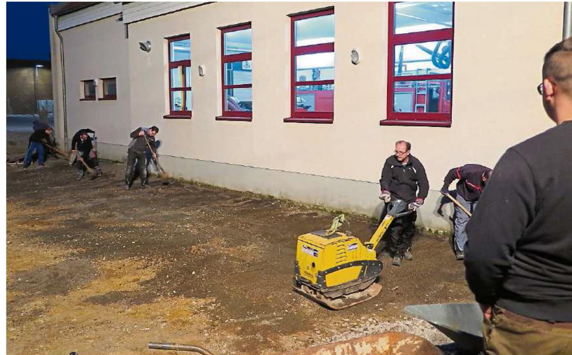
Alle vorbereitenden Arbeiten bis zum Erstellen des Rohbaus, wie hier beim abendlichen Einsatz mit Rüttelplatten, werden in ehrenamtlicher Eigenleistung der Wehr erbracht. Foto: Wilhelm Meyer
