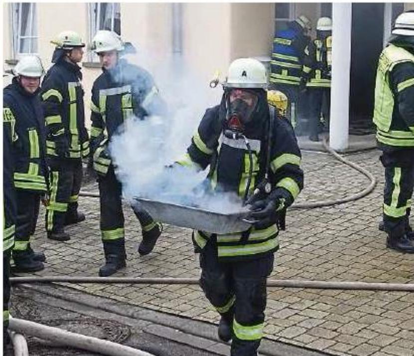
Per Hand wurden die verkohlten Pellets aus der Heizungsanlage geräumt und ins Freie geschafft, um sie dort abzulöschen. Foto: Feuerwehr
